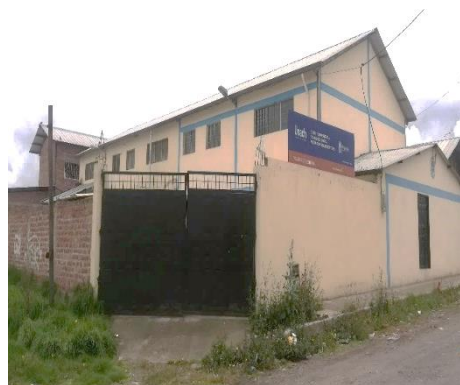
INGRESO PRINCIPAL Puerta metálica de 4.60 x 2.50 m
