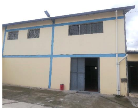
INGRESO CETTEPS Puerta metálica de 2.50 x 3 m
