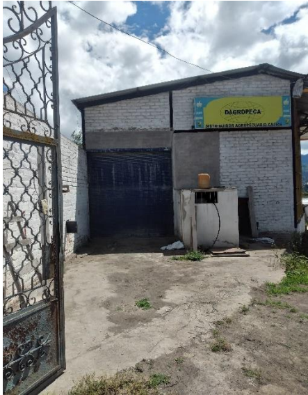
Figura 1. Instalaciones Externas "DAGROPECA"
