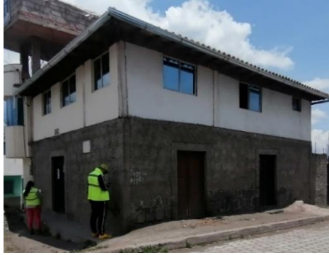
Figura 10. Cubierta de Zinc en vivienda de dos pisos.
