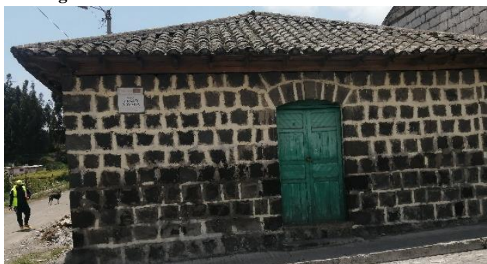
Figura 13. Muros estructurales en fachadas de vivienda.
