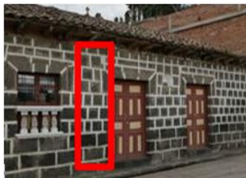
Figura 12. Muro de piedra en fachada principal de vivienda.
