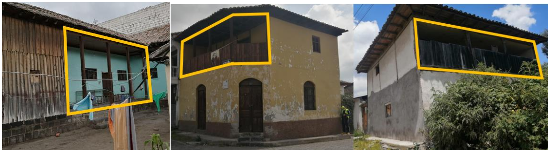
Fuente: Elaboración propia, fotografías tomadas por los autores
