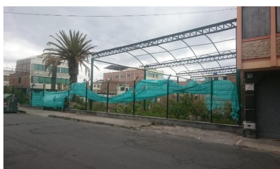
Figure 2 estructura de acero tipo nave industrial
