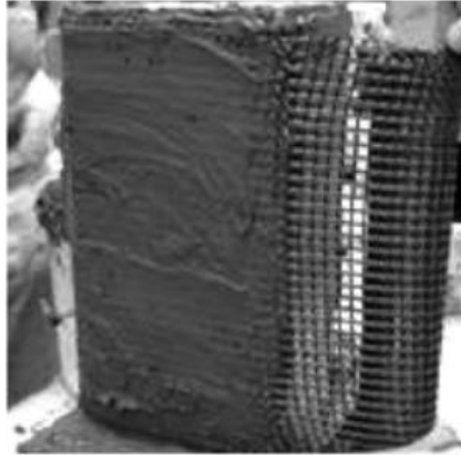
Figura 15, Colocación del encamisado de compuestos FRCM.
