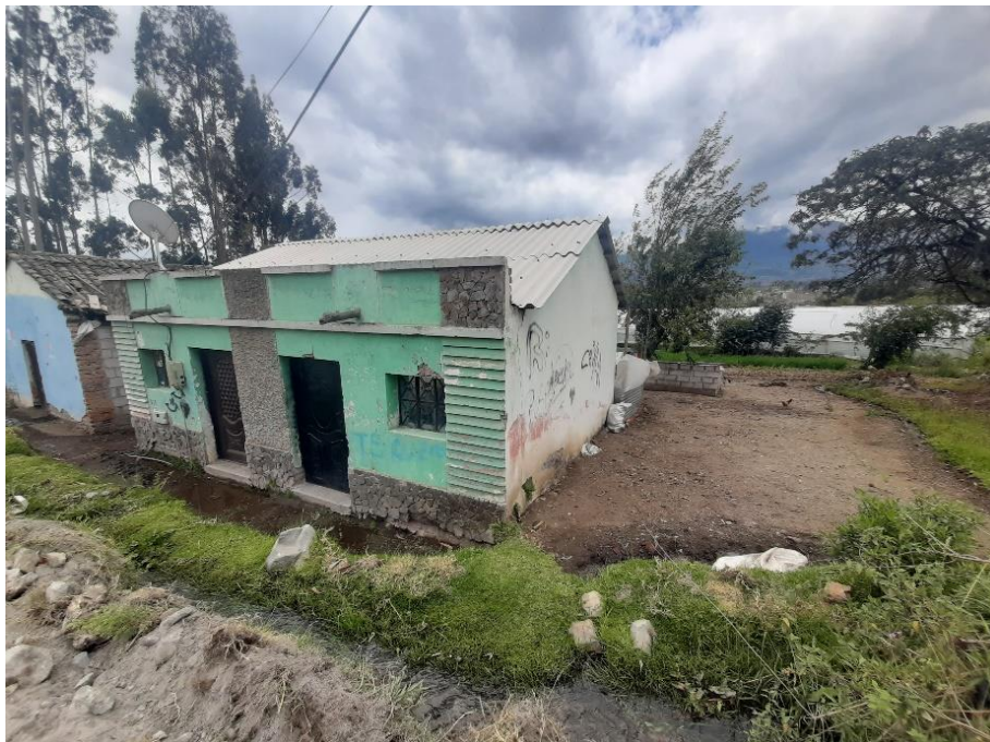
Figura 21 Anexo 4: Vivienda cerca al punto 5 (V5, coordenadas WGS84 765477.00 m E, 9819075.00 m S).
