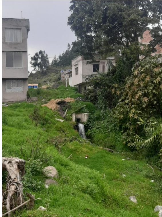
Figura 26 Anexo 7: Canal de aguas residuales (Coordenadas WGS84 765310.51 m E, 9818739.16 m S).
