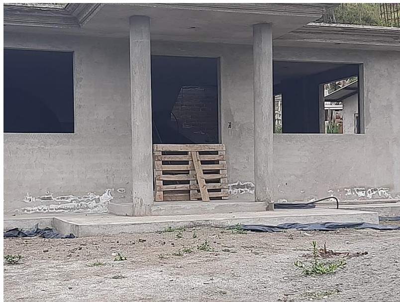
Figura 29 Anexo 9: Presencia de partículas de Yeso en la base de la fachada (V11_2, coordenadas WGS84 764921.64 m E, 9818717.03 m S).
