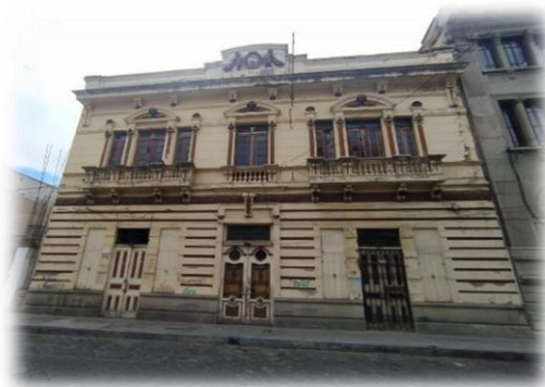
Figura 14 Fachada del edificio de la ENFE
