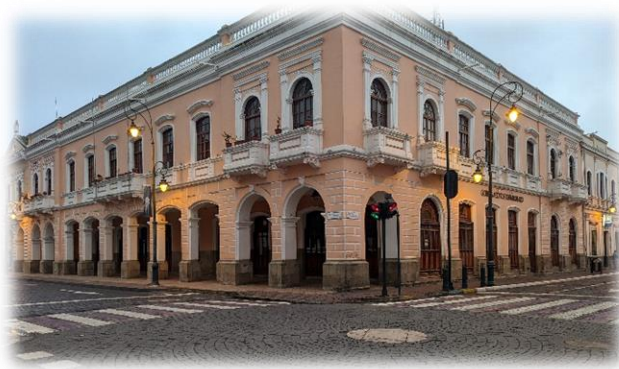
Figura 7 Edificio del Palacio Municipal
