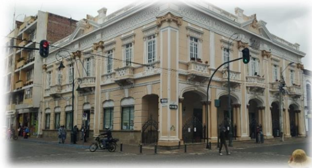
Figura 8 Edificio del Servicio de Rentas Internas (SRI)
