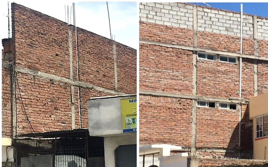
Ilustración 10. Cruce de tuberías en Vigas
