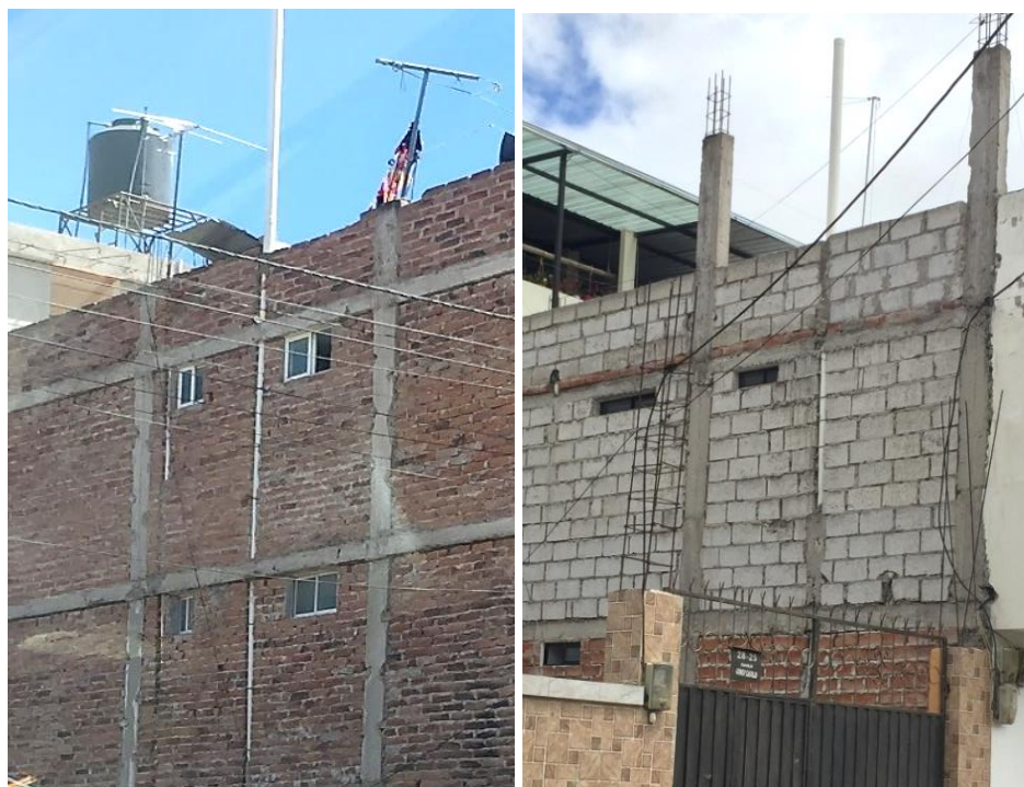
Ilustración 12. Cruce de tuberías por centro de Viga
