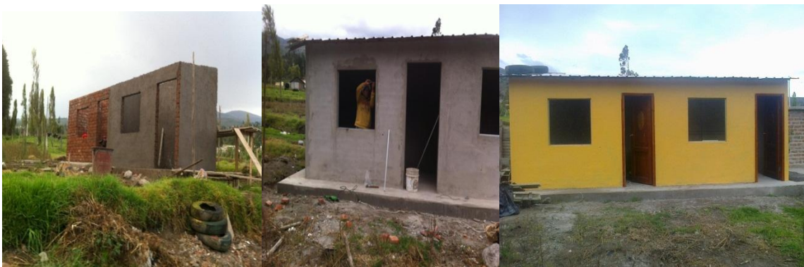
Fotografía 5: Construcción de las paredes y colocación de techos, puertas, ventanas y pintura de las cabinas para el jardín vertical. Responsable: Javier Tandazo.
