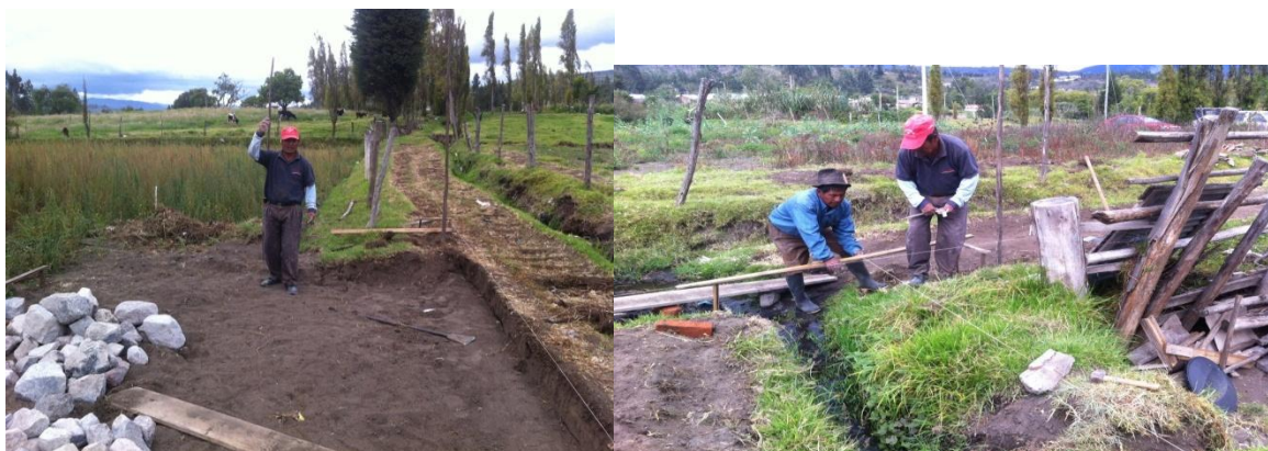
LIMPIEZA DEL TERRENO Y MEDICIÓN DE LAS MEDIDAS PARA LAS CABINAS.
