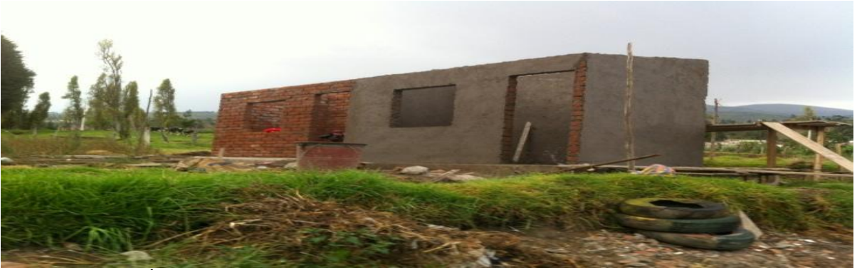
CONSTRUCCIÓN DE LAS PAREDES.
