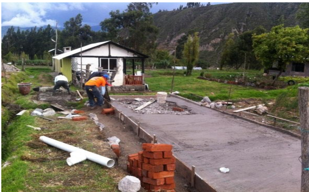
CIMENTACIÓN DE LAS CABINAS DE ENSAYO.
