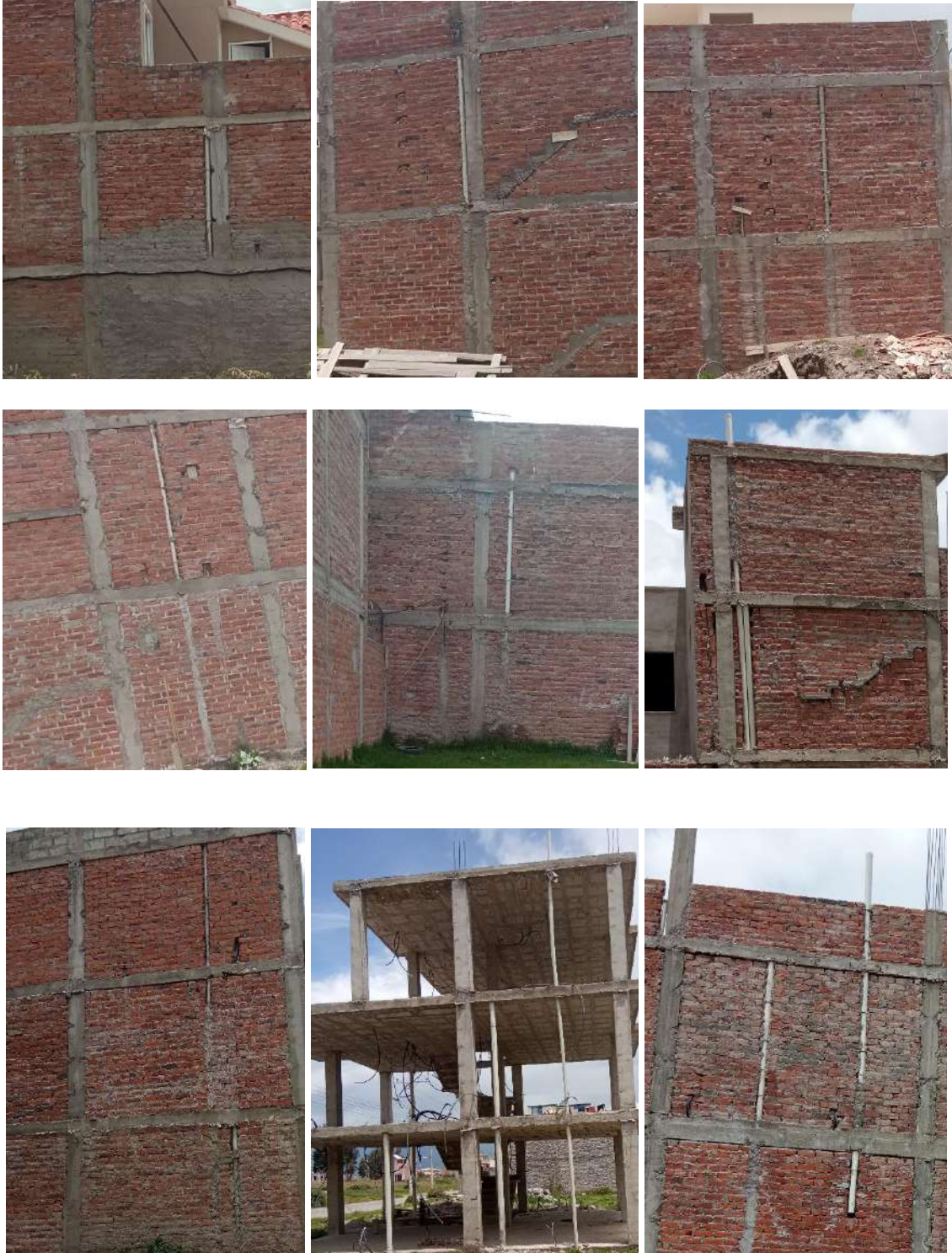
Anexo 2: Resultados de las inspecciones visuales
