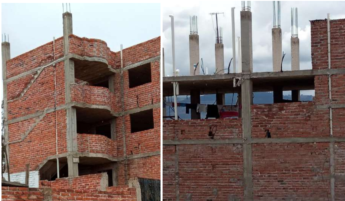
Figura 16.- Bajantes de agua atravesando vigas en estructuras en construcción en "El Rosario" Elaborado por: Rivera (2021)
