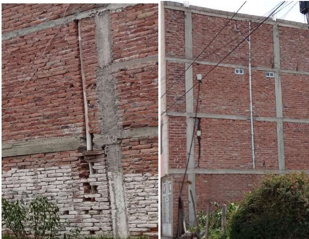
Figura 17.- Tuberías embebidas en vigas Elaborado por: Rivera (2021)
