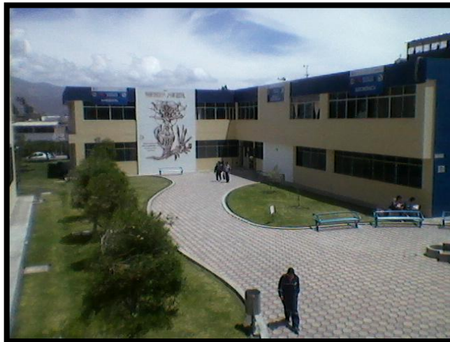
Fotografía 2: Facultad de Ingeniería – UNACH – Bloque B.
