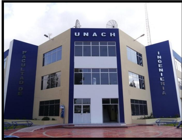
Fotografía 1: Facultad de Ingeniería – UNACH – Bloque A.
