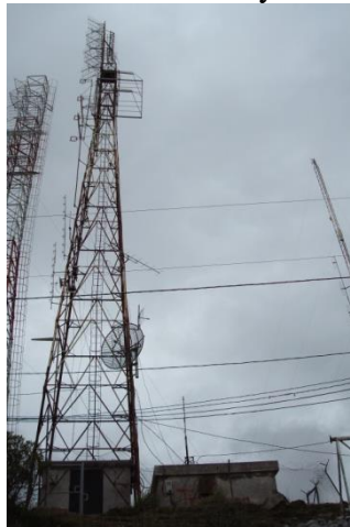
Figura 3.29. Ubicación de la antena Tx y Rx en el Cerro Cacha
