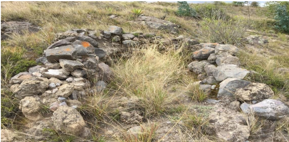
Figura 4. Restos de construcción
