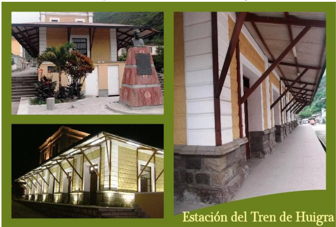
Fotografía N°11. Estación ferrocarril Huigra
