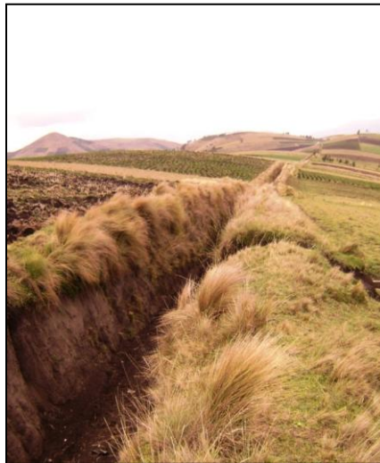
Fotografía 1: Zanja que define el lindero comunitario
