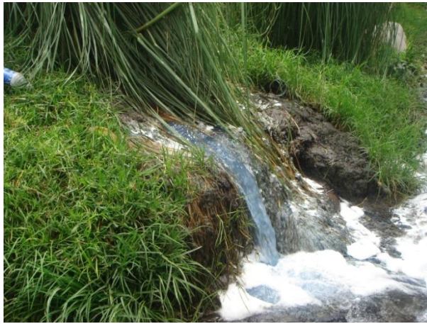
• PUNTO 12(DESCARGA AGUAS RESIDUALES INDUSTRIALES)
