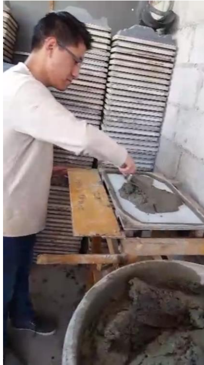
Fig. 62 Fabricación de teja por tesista
