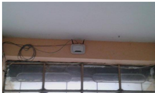
Ilustración 100 AP Edificio N°1 Fuente: Mauricio Estrada – William Adriano
