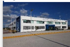
Figura 18. Edificio BUAP. Fuente: bing.com
