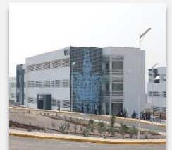
Figura 19. Edificio BUAP. Fuente: bing.com
