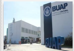
Figura 17. Edificio BUAP. Fuente: bing.com
