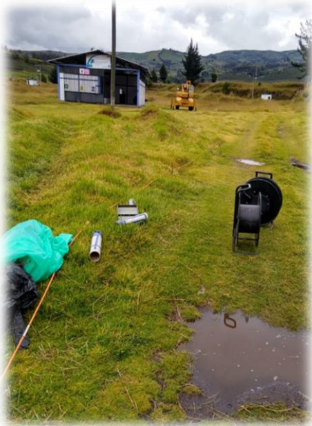
Tendido de cables.
