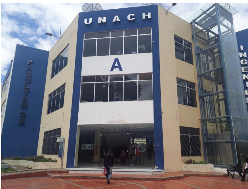
Ilustración 8. Aplicación del instrumento de inspección en el bloque A de Ingeniería.
