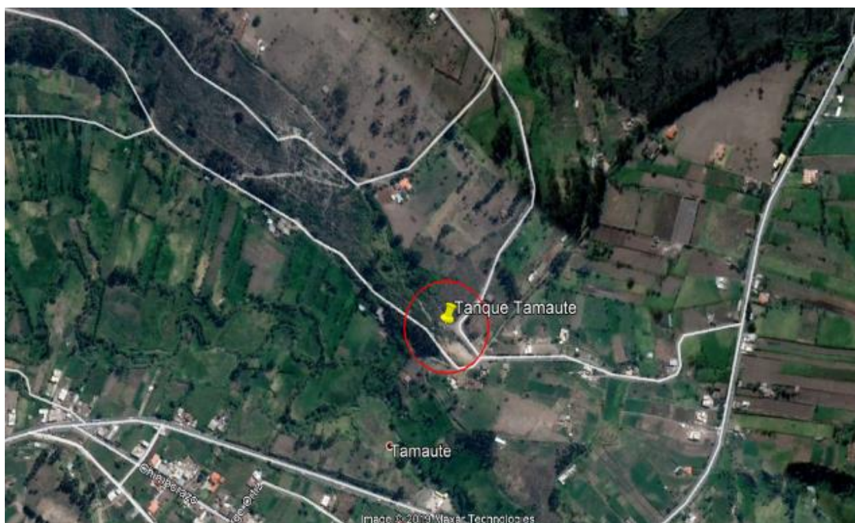
Figura 3. Depósito de agua cruda de la vertiente el soltero ubicada en la comunidad de Tamaute.
