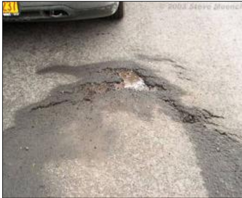
Ilustración 18. Grietas de desplazamiento.
