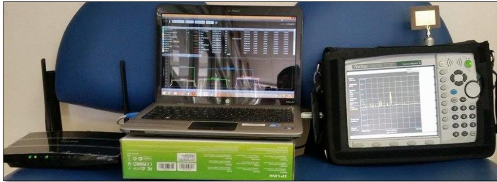
Figura 70. Medición de la antena.
