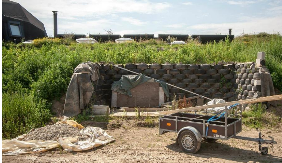
Ilustración 4 Pared perimetral posterior Fuente: ecoinventos.com
