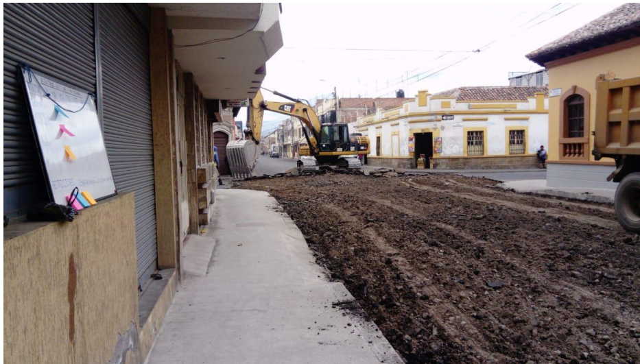
Figura 12. Proyecto, reasfaltado de la calle Gaspar de Villarreal.
