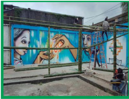
Fuente: Eloisa Parra Descripción: Construcción de aula ecológica
