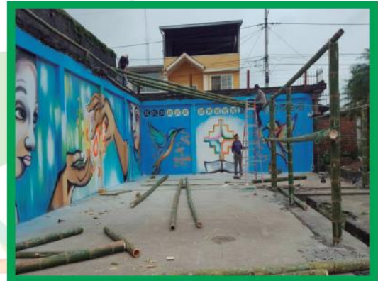
Fuente: Eloisa Parra Descripción: Construcción de aula ecológica
