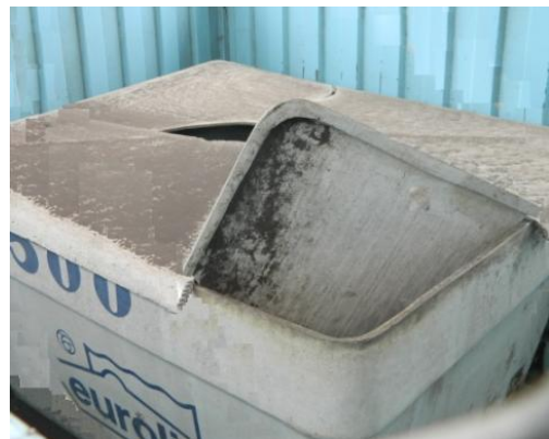
Foto 5. Tanque de cloración manual Fuente: Autor
