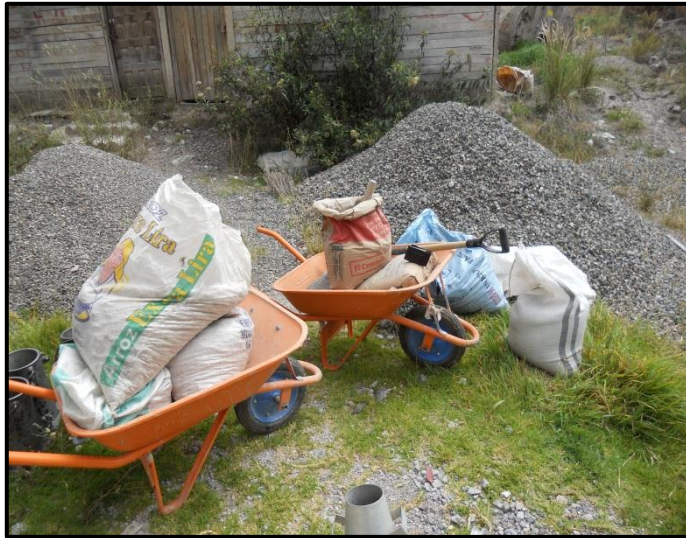
Figura 26: Materiales empleados en la elaboración del concreto
