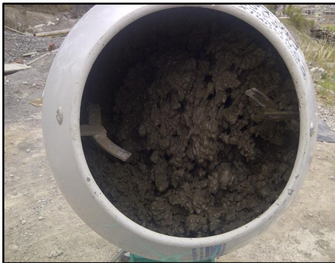
Figura 27: Elaboración del concreto de alta resistencia
