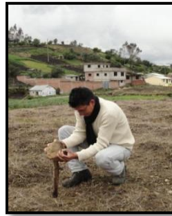
Figura 4. ESTACAR EN UN LUGAR FIRME Y VISIBLE PARA LA UBICACIÓN DEL PRIMER PUNTO
