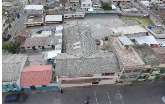
Figura 18. Fotografía aérea (Bloque 2)
