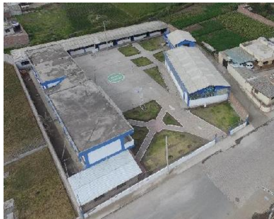
Figura 21. Fotografía aérea (Bloque 3)
