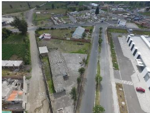
Figura 16. Fotografía aérea (Bloque 1)
