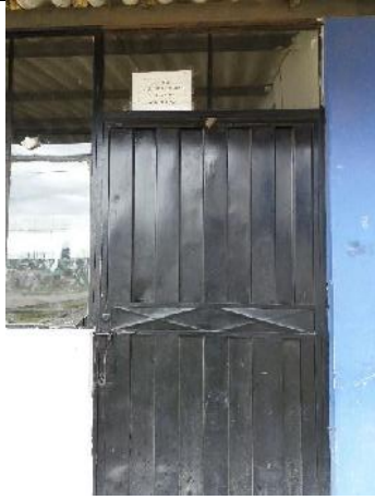
B24 Tercero Bachillerato “Corte y Confección”
