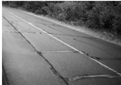
Gráfico 32: Grietas de reflexión.
