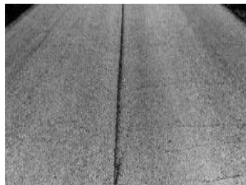
Gráfico 34: Grietas longitudinales.
