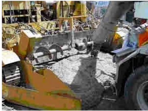
Gráfico 77. Colocación del hormigón, directamente desde el camión mixer.
