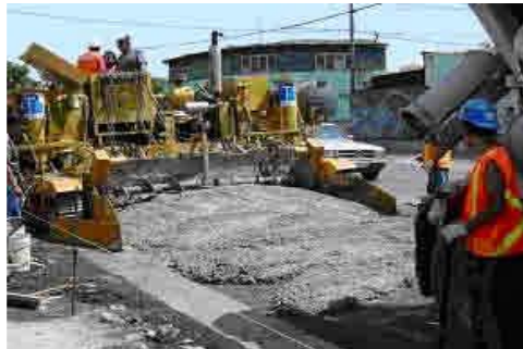
Gráfico 78. Tren pavimentador en faenas de hormigonado.
