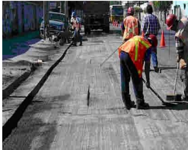
Gráfico 75. Faenas de limpieza con escobillón para las partículas grandes.
