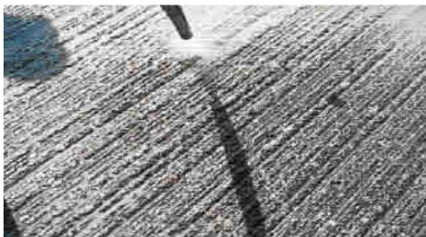
Gráfico 76. Faena de limpieza más profunda, usando aire comprimido, para remover las partículas más pequeñas.
