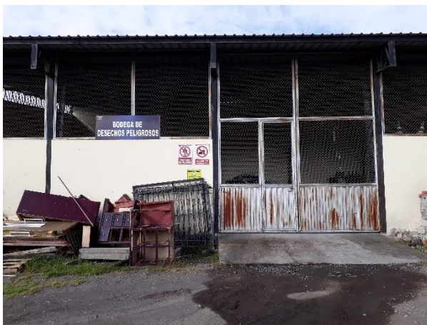
Bodega de desechos peligrosos
