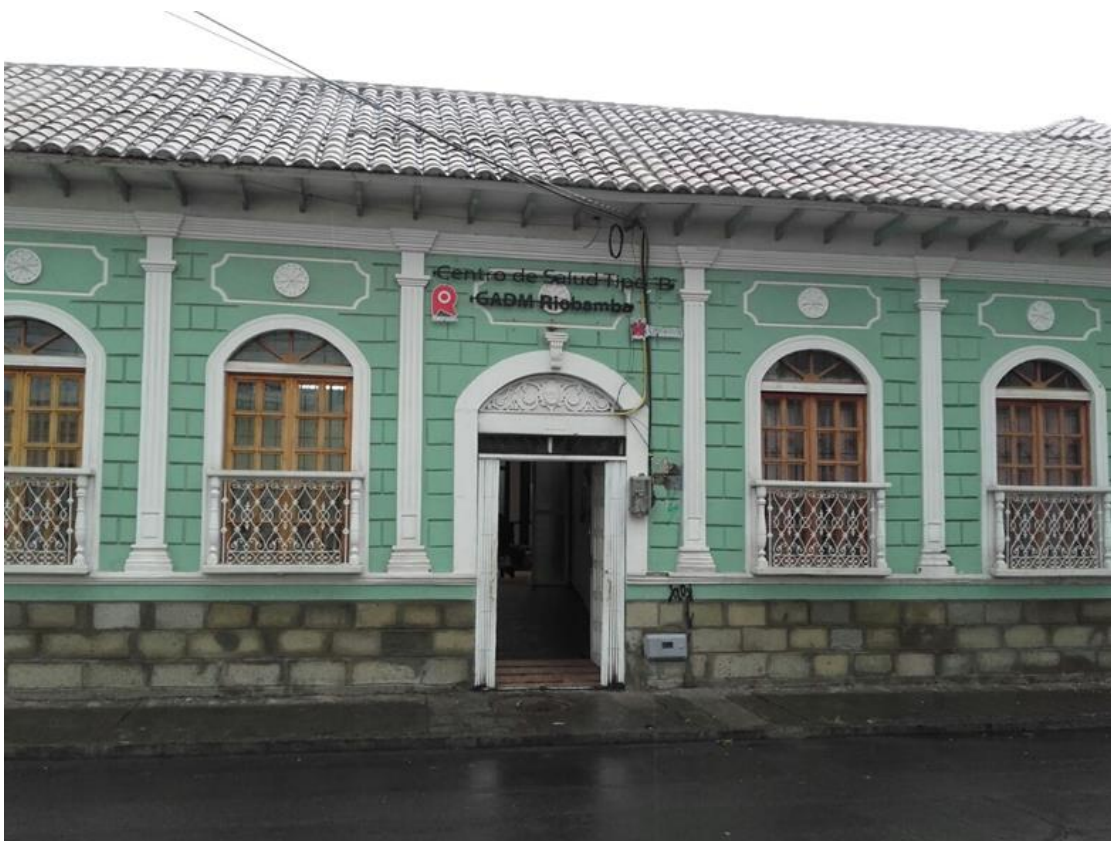
Centro de Salud GADM RIOBAMBA. Vista Exterior. Larrea entre Villarroel y Chile. Riobamba-Ecuador.
