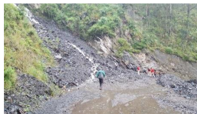
Derrumbe en la vía principal
