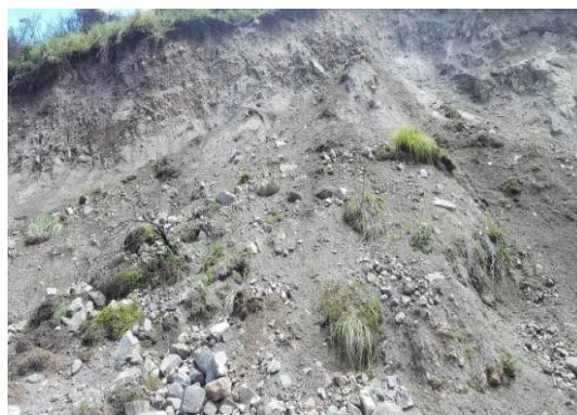
2. Zona erosionada sector de la Mina.
