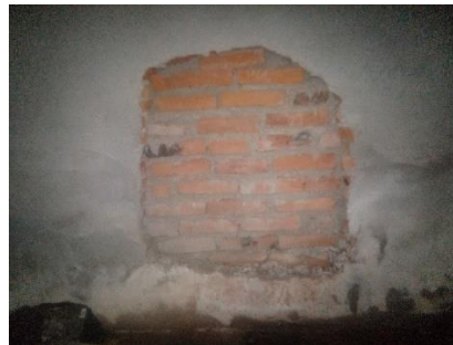
Ilustración 1. Mampostería Edificio A
