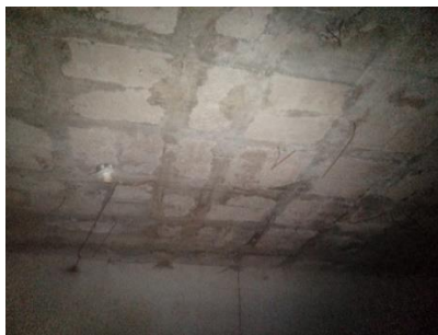
Ilustración 7. Acero corrugado y visible
