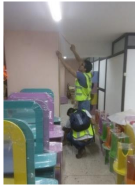
Ilustración 3. Toma de altura entrepiso Edificio A.
