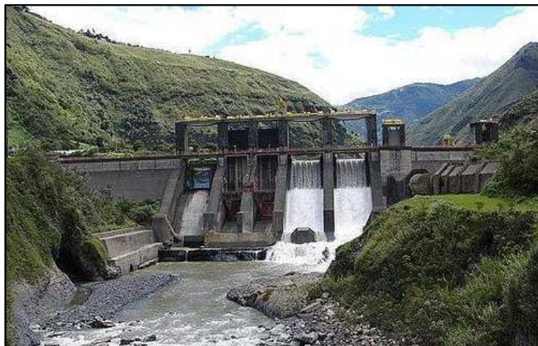
Ilustración 6. Proyecto Hidroeléctrico Sopladora
