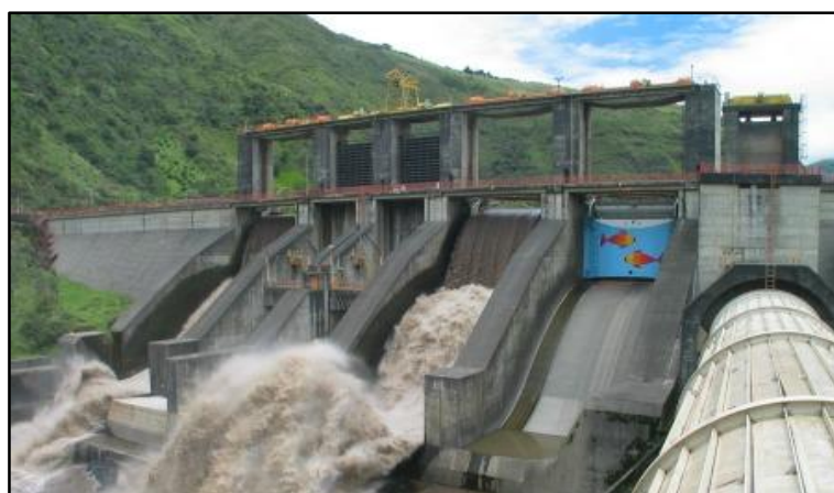
Ilustración 9. Proyecto Hidroeléctrico Delsitanisagua
