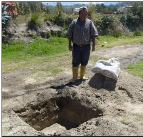
Figura 24. Excavación de Calicatas.
