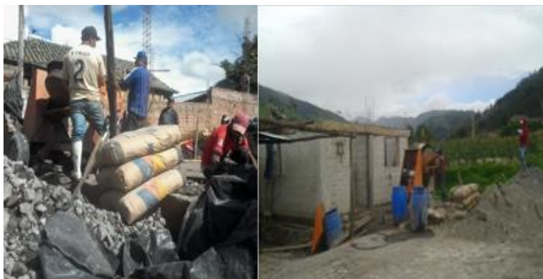
Figura 7: Medición de desperdicios de cemento
