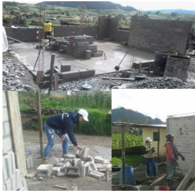
Figura 8: Medición de desperdicios de bloque
