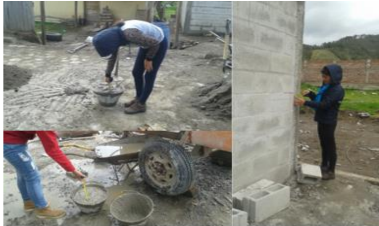
Figura 6: Medición de desperdicios de hormigón
