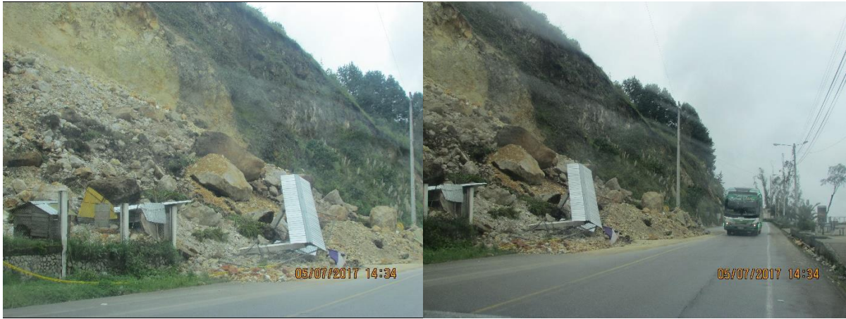
Problemas por deslizamiento de taludes
