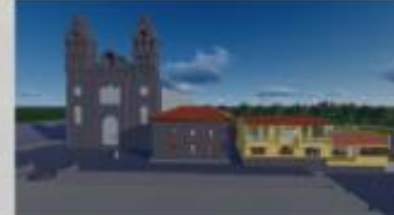
VISTA EXTERNA - FACHADA FRONTAL DE CONJUNTO
