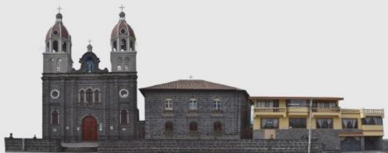
FACHADA CALLE NAVEDA
