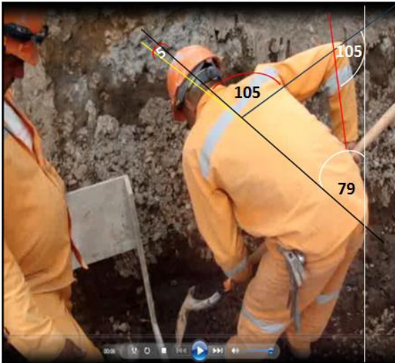
Figura N° 10: Evaluación del Puesto de Trabajo: Albañil. Método Rula.
