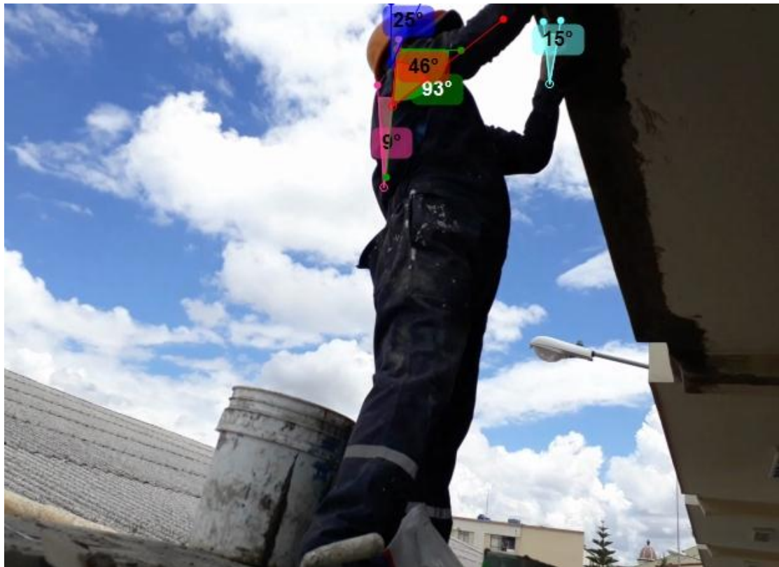
Fotografía 17 Evaluación del Personal de Mantenimiento
