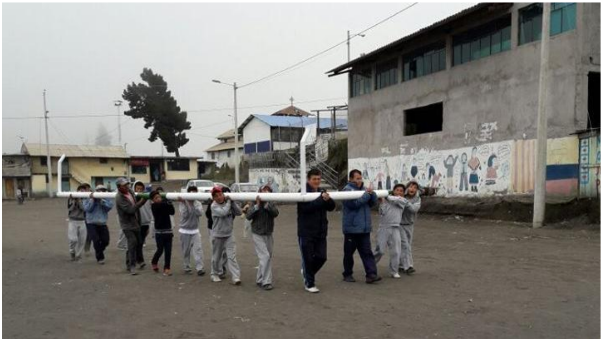
Instalación de poste con la ayuda ciudadana.
