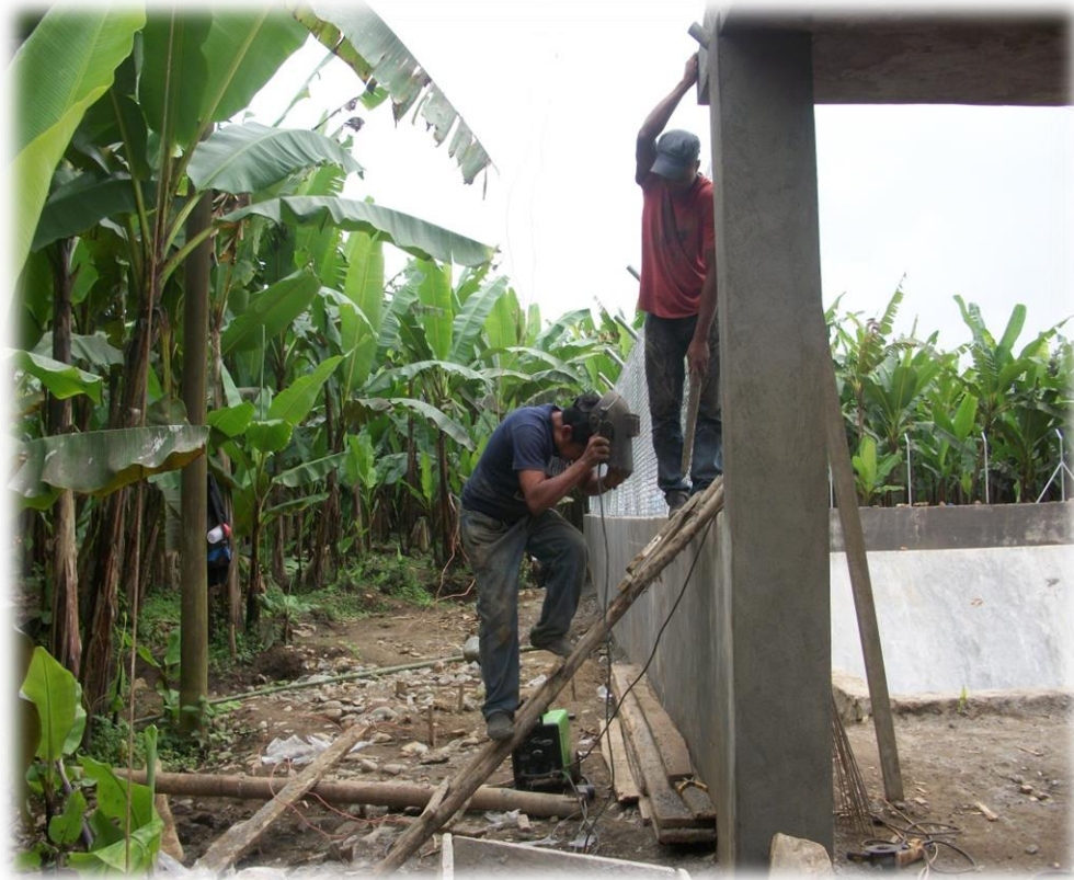
Malla electrosoldada para cerramiento
