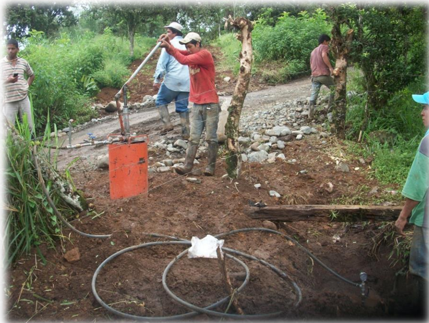
Suministro, Instalación y Prueba de tubería
