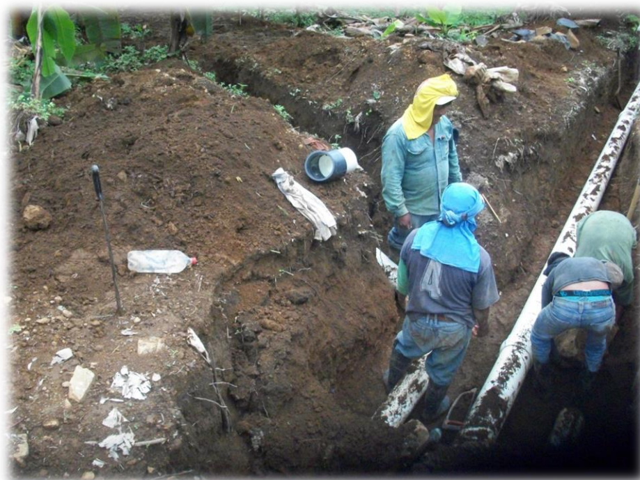
Suministro, Instalación y Prueba de tubería
