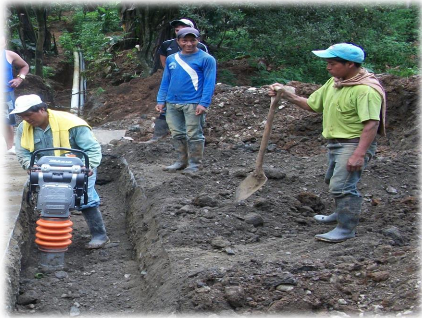
Relleno manual compactado
