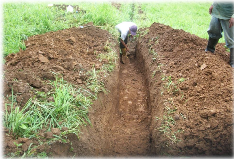
Excavación manual para instalación de tubería
