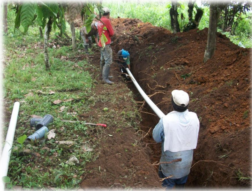
Suministro e instalación de tubería
