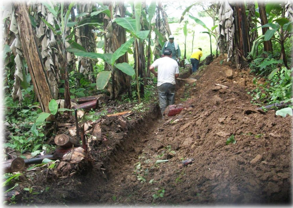
Excavación manual para instalación de tubería
