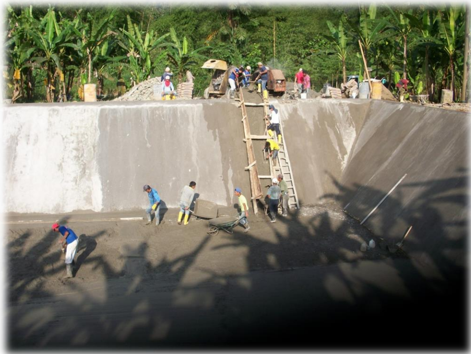
Hormigón de f'c=210 \text{ Kg/cm}^2
