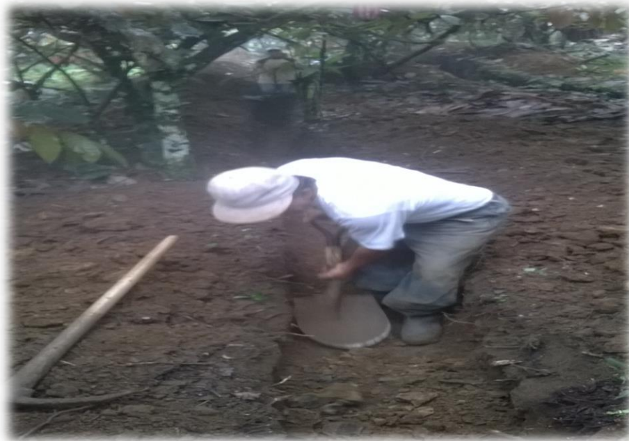
Excavación manual para instalación de tubería
