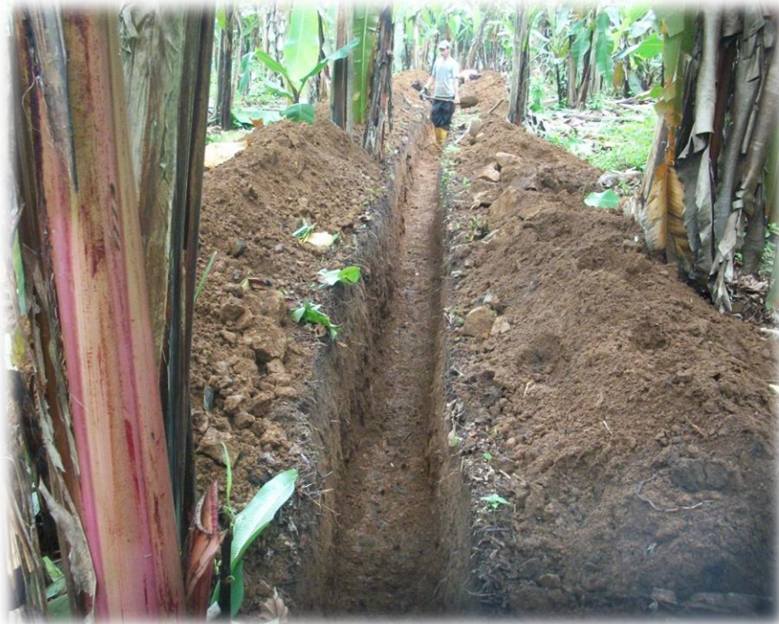
Excavación manual para instalación de tubería
