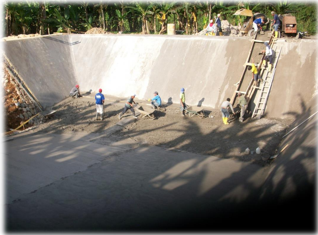
Hormigón de f'c=210 \text{ Kg/cm}^2
