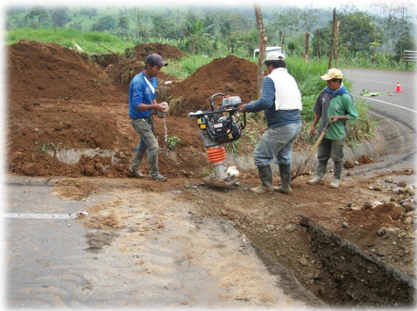
Relleno manual compactado
