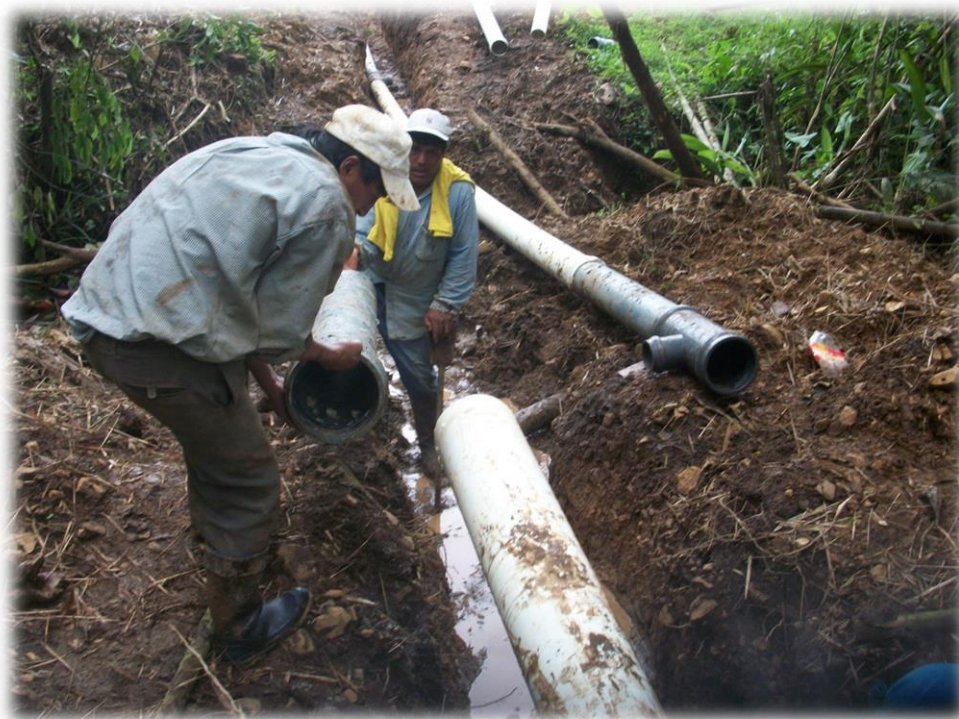
Suministro, Instalación y Prueba de tubería
