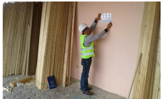
6. Colocación de señalética.
