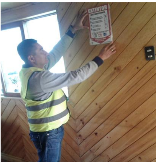
7. Colocación de señalética.
