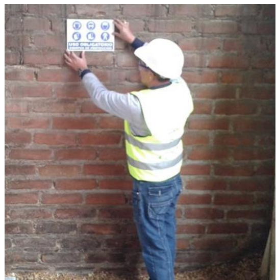
8. Colocación de señalética.
