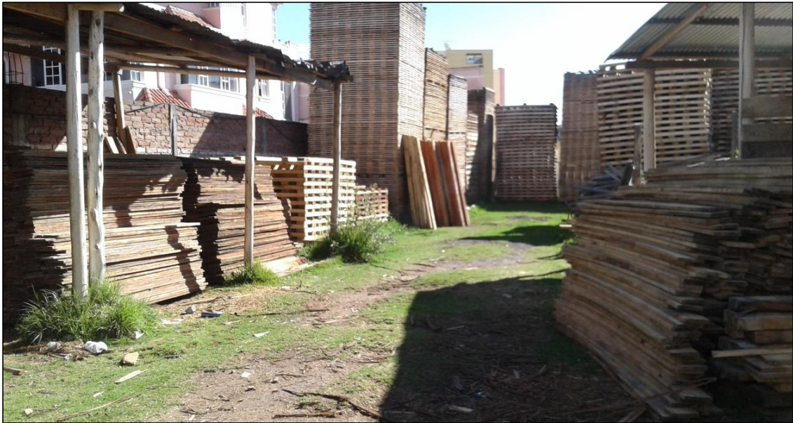
Imagen N° 4.4. Patio de acopio de la madera.
