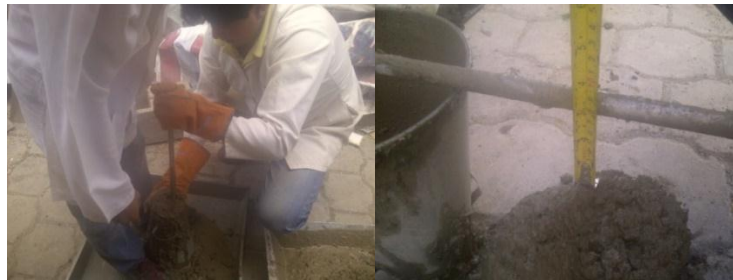
Figura 22: Verificando la consistencia del Concreto mediante el cono de Abrams.
