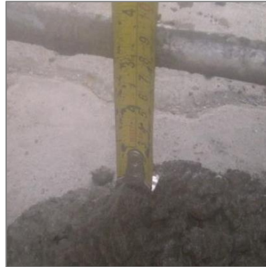
Figura 35: Medición del Asentamiento.
