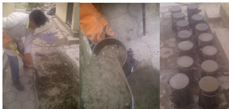
Figura 21: Elaboración de cilindros del concreto.
