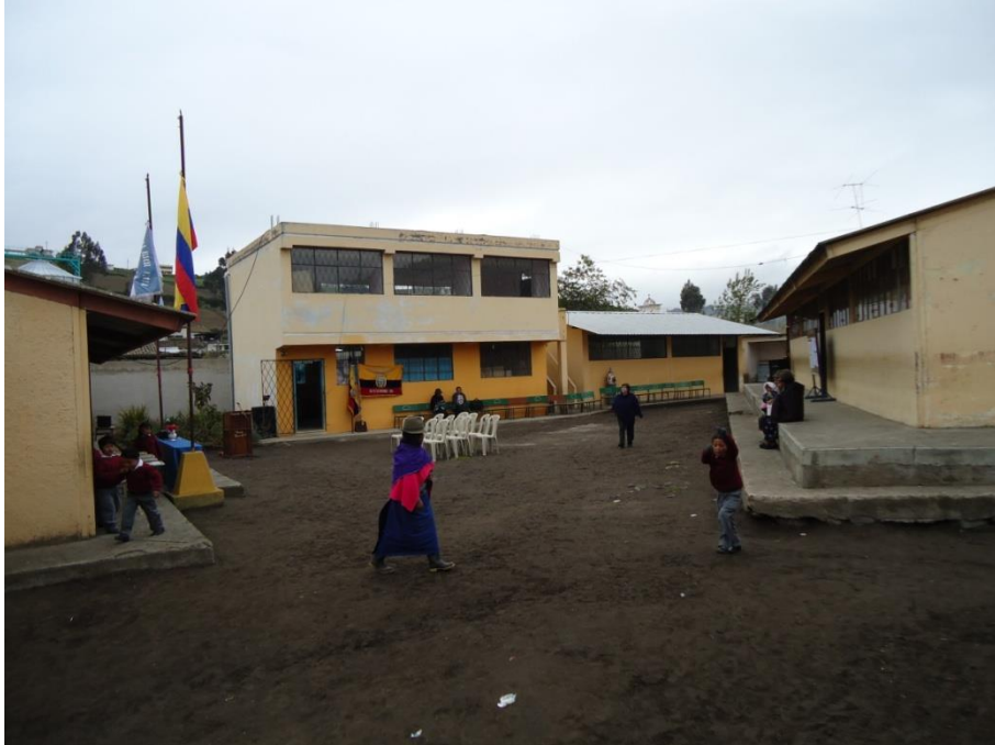
Fotografía 2. Vista panorámica interna de la Escuela Fiscal Mixta Tomás Oleas Arrieta
