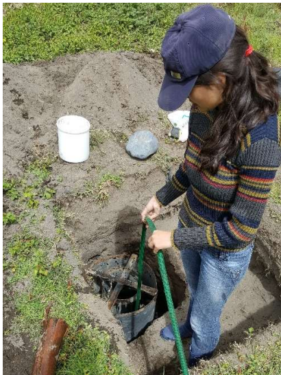
Fotografía 13. Colocación y llenado de agua en el infiltrómetro doble
