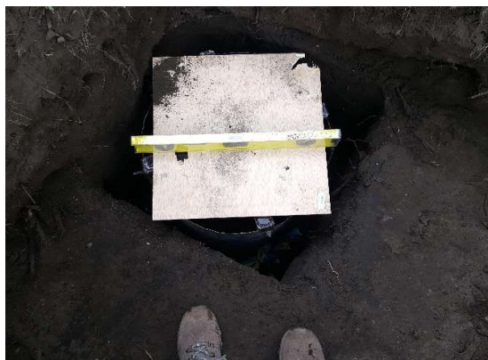
Fotografía 11. Nivelación del infiltrómetro de cilindro doble.
