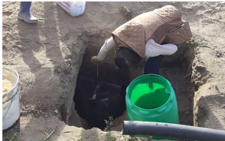
Fotografía 16. Toma de datos de infiltración.
