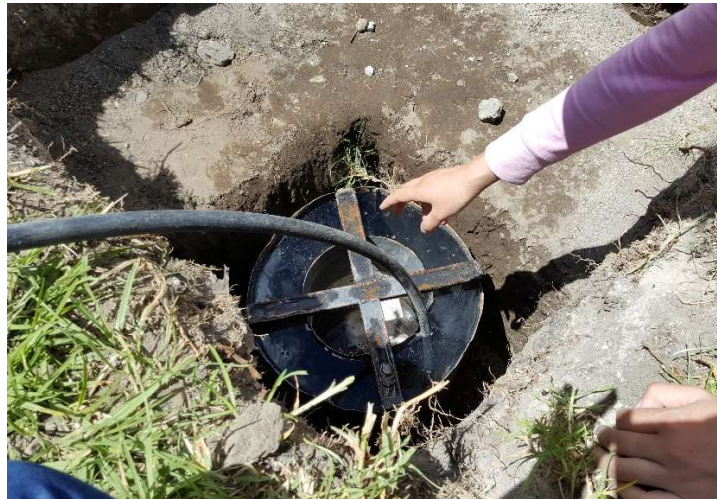
Fotografía 2. Ensayo de Infiltración
