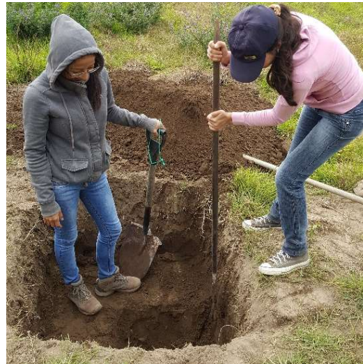
Fotografía 7. Excavación calicatas. (1 x 1 x 0.50) m
