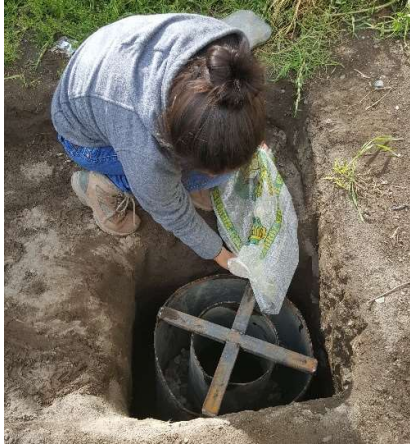
Fotografía 12. Colocación de grava en el infiltrómetro doble
