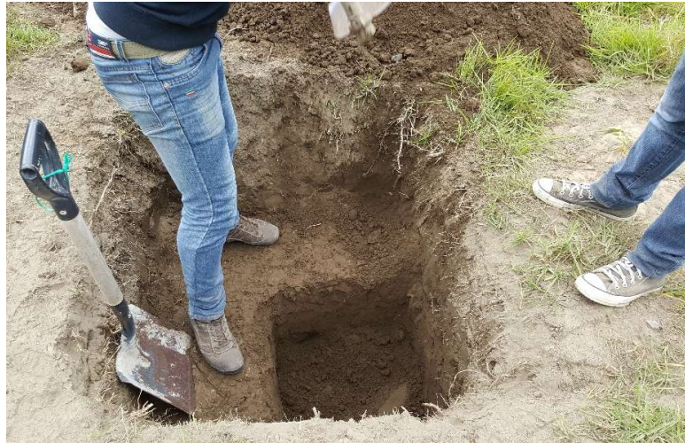
Fotografía 1. Excavación de Calicata
