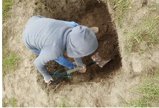
Fotografía 6. Excavación calicatas. (1 x 1 x 0.50) m
